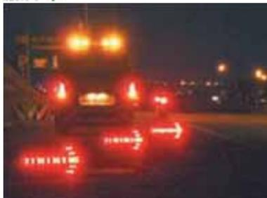
流れる矢印板は、道路上での工事の際、作業現場の注意標識として車両誘導または、歩行人誘導等のため工事現場の両端に設置します。設置後、操作器(無線リモコン)からの操作で、決められたパターンで矢印板を点灯させることが可能となっており、操作範囲は、特定省電力無線により300m程度を確保しています。
